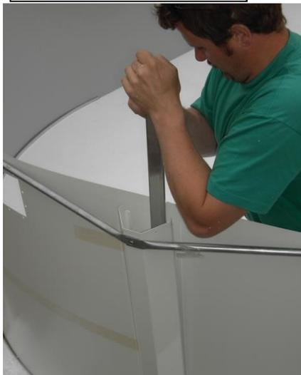
**ACHTUNG:** In manchen Gegenden muss das Becken geerdet werden. Um Schäden an der Folie zu vermeiden kleben Sie die Stahlmanteloberkante durchgehend mit dem mitgelieferten stoffarmierten Klebeband ab.
