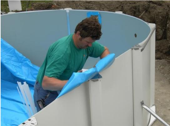
Ziehen Sie die Folie über die Stahlwand und befestigen Sie die Folie provisorisch mit dem mitgelieferten Poolcoping rund um die Stahlwand.
