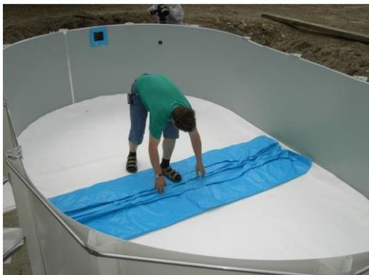
Die senkrechte Schweißnaht der Folie dient als Ausgangspunkt.
