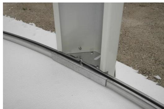
Im nächsten Schritt werden dann gleich die Versteifungsrohre mit den Stehern verschraubt. Achten Sie darauf, dass die Steher senkrecht in der Waage sind.
