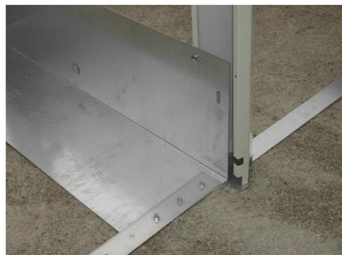
Wenn nun alle Teile miteinander verschraubt sind, richten Sie die Mittelkonstruktion so aus, dass beide geraden Teile parallel zueinander liegen.
