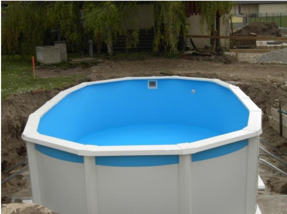
Ihr Schwimmbecken ist nun fertig montiert. Es fehlen nur noch Filter, Skimmer, Einströmdüse und etwaige weitere Einbauteile. Entnehmen Sie die Montageanleitungen für diese Teile aus den jeweiligen Beschreibungen.
