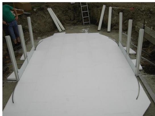
In weiterer Folge werden die Bodenschienen im Radius des Beckens aufgelegt und mit den Bodenschienenverbindungsstücken verbunden.
