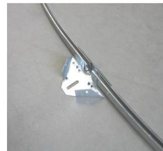
Nachdem Sie alle Bodenschienenverbindungsstücke zusammengesteckt haben, montieren Sie nun die Steher für die Rundung.
