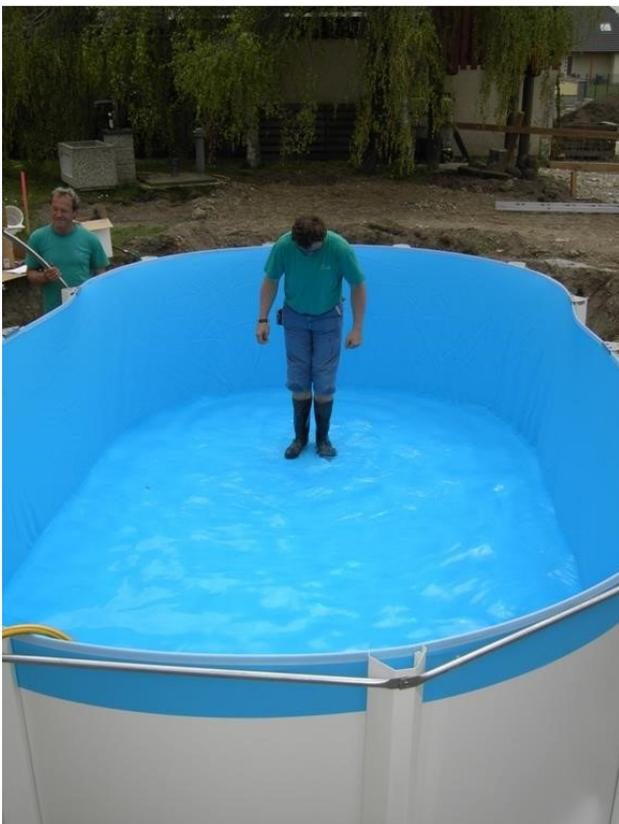
Wenn der Boden fertig geglättet ist, wird die Folie über die Stahlwand nachgespannt und rundherum mit dem Poolcoping fixiert. Schneiden Sie die überschüssige Folie jedoch nicht ab.
